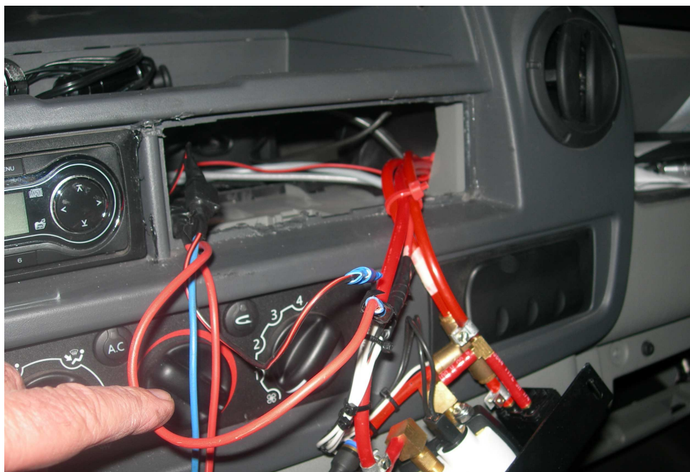
Vista conexiones eléctricas y neumáticas en las válvulas de inflado
